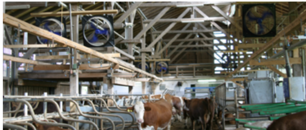
Ventilatorenanordnung im Milchviehstall (LfL Bayern)
